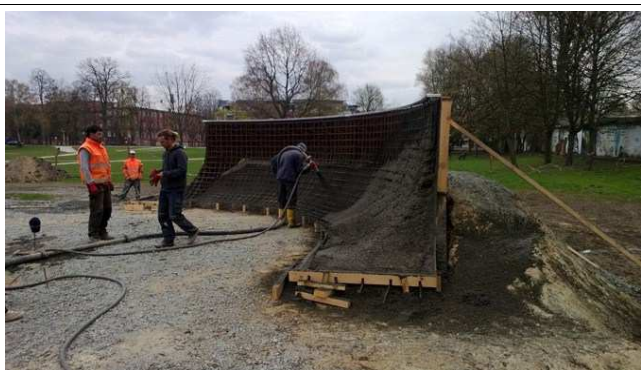
Prace metodą torkretowania na osiedlowym skatespocie.
