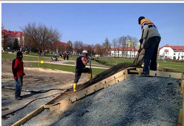
Jak widać tego typu prace są dość proste i powszechnie stosowane...
