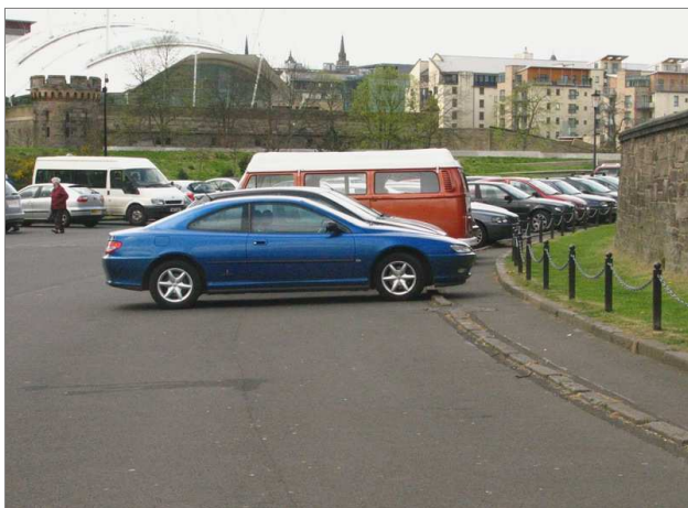
W takiej sytuacji można zastosować progi ustawione w pewnej odległości od krawężnika jak w Edynburgu, gdzie tym sposobem wygradzono miejsca parkingowych z wyasfaltowanej powierzchni, dodatkowo zostawiając miejsce z przodu pojazdów dla kierowców i pasażerów.
