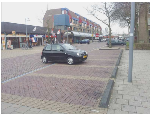
Holandia. Próg oporowy informuje kierowcę, gdzie kończy się miejsce parkingowe i utrudnia wjazd poza tę granicę.
