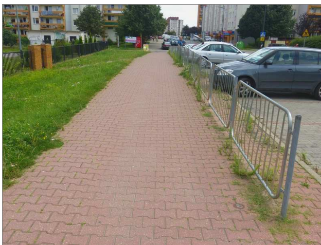
Ul. Bursztynowa. Odradzany sposób separacji chodnika i parkingu za pomocą barierki. Bariereka dodatkowo zwęża chodnik i zwiększa dyskomfort pieszych.
