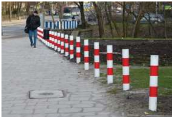
Zupełnie zbędne słupki między chodnikiem a trawnikiem na ul. Fabrycznej, naprzeciwko Gali.
