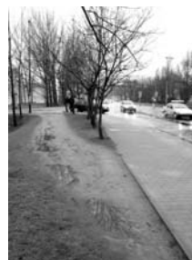
„Centrum Zana”. Ścieżka do Leclerca będąca rezultatem braku konsekwencji między układem chodnika po obu stronach wjazdu na parking. Fot. M. Skrzypek.
